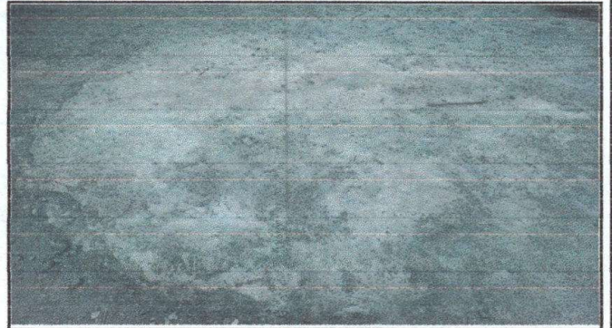
Foto 2: Sustrucción de piso de torta de concreto
