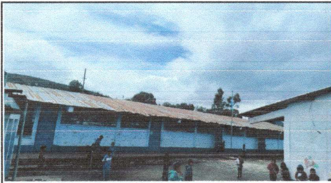
Foto 3: Sustrucción de lámina, por lámina troquelada aluzinc calibre 26
