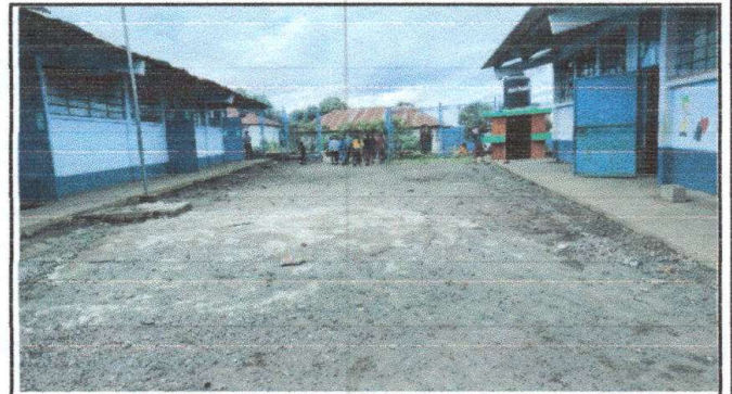
Foto 4: Sustrucción de piso de torta de concreto
